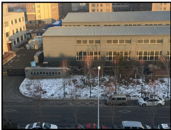
东侧长春慧邦科技有限公司
